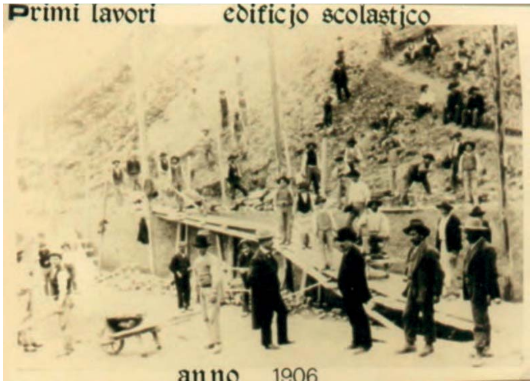
Il cantiere per la costruzione dell'edificio.
