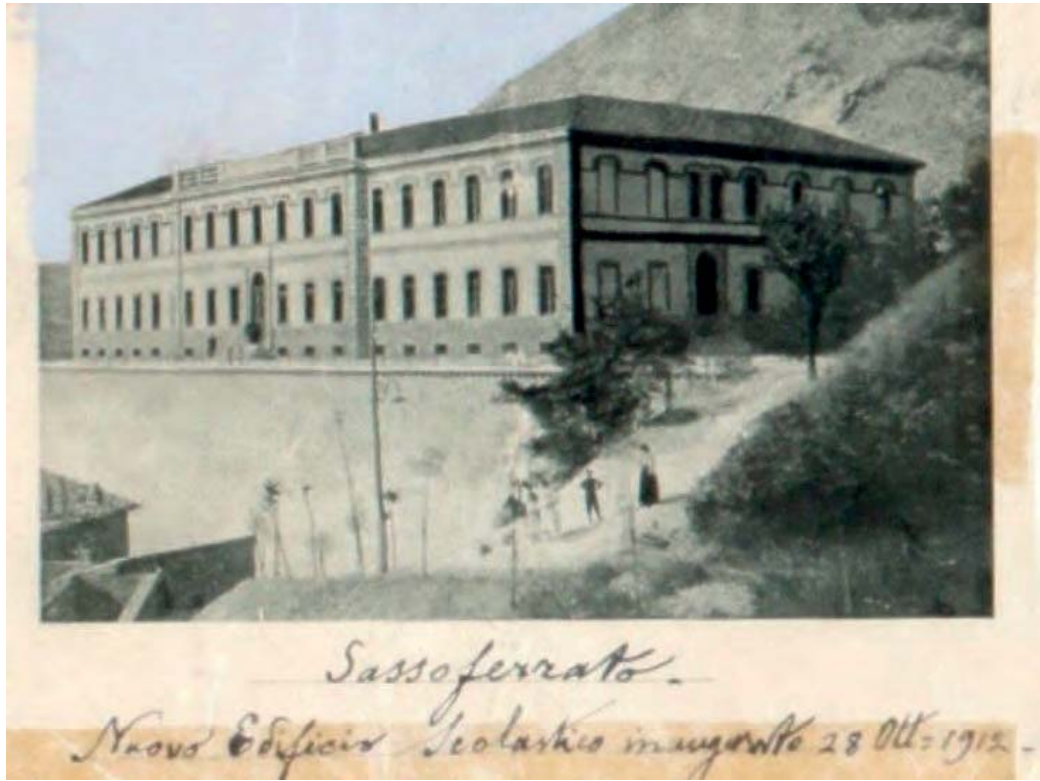
Il nuovo edificio scolastico in una foto d'epoca.
